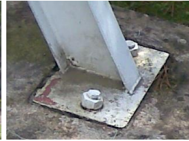
Appuis fixes ou rotules en construction métallique réalisations idéales et réalisation économique courante.
