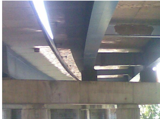
Construction mixte acier-béton.
