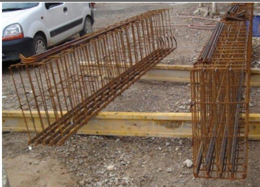
Ferrailage. espace dessin, continuité ou non des armatures
