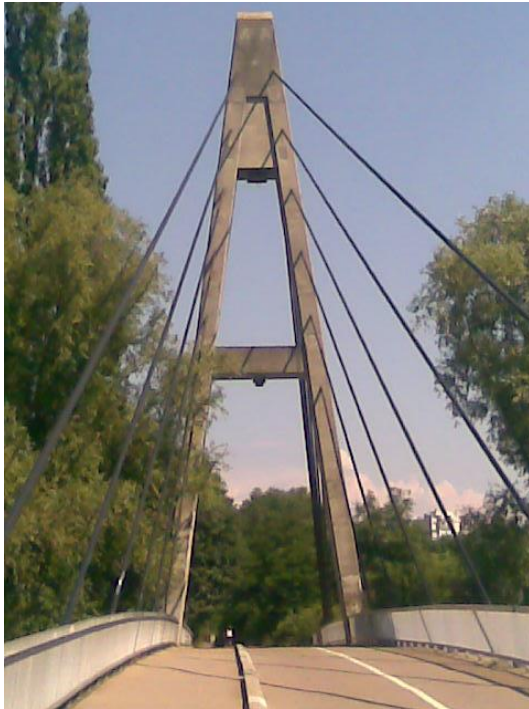
Ponts à haubans
