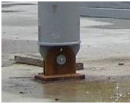
Appuis fixes ou rotules en construction métallique réalisations idéales et réalisation économique courante.
