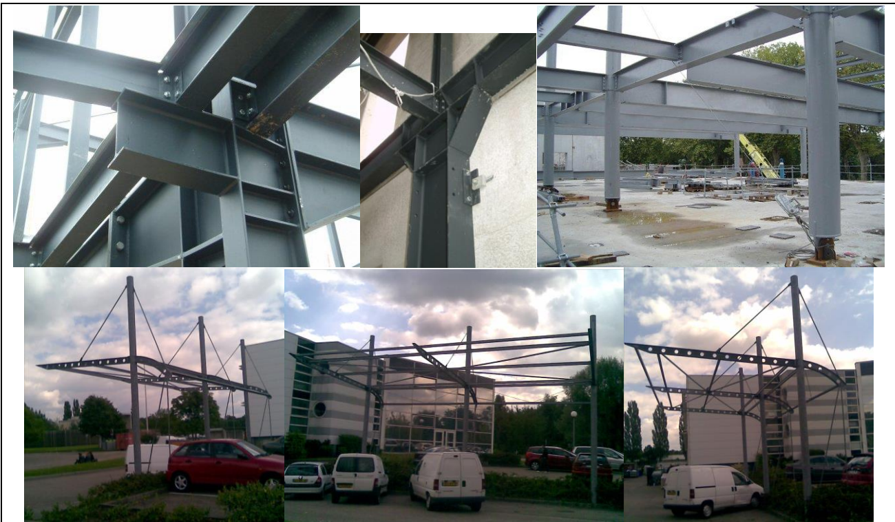
Constructions métalliques. espace dessin, liaison âme et liaison semelles
