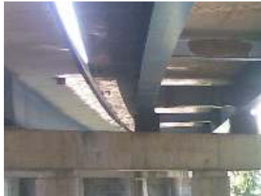
Construction mixte acier-béton.
