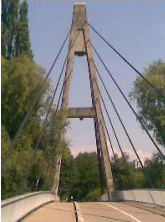
Ponts à haubans
