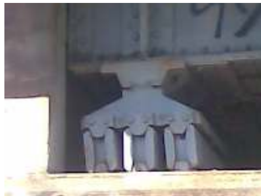
Réalisation pratique d'un appui glissant pour un pont métallique de chemin de fer.
